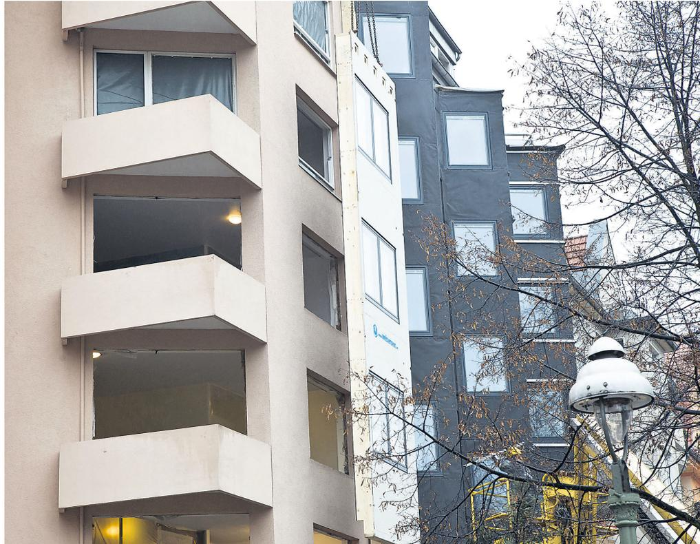
**Schicht für Schicht.** Das Apartmenthaus in der Burgemeisterstraße in Tempelhof bekommt eine „schlaue Haut“ verpasst: Auf die alte, rosafarbene Fassade (vorne) werden mit einem Kran große, vorgefertigte Holzverblendungen aufgebracht (Mitte). Schwarze Unterspannbahnen (hinten) machen die Konstruktion wetterfest. In wenigen Tagen folgt die neue Fassade aus Schichtstoffplatten. *Foto: Georg Moritz*
